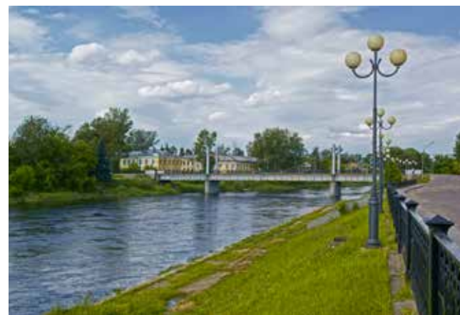
■ Пешеходный мост через р. Тверца
